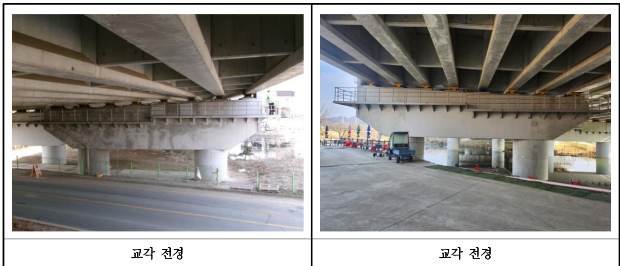
【사진 1.3.10】 교각 전경
