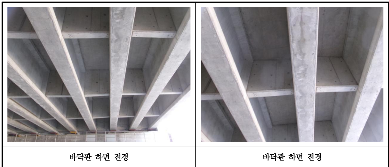
【사진 1.3.2】 바닥판하면 전경
