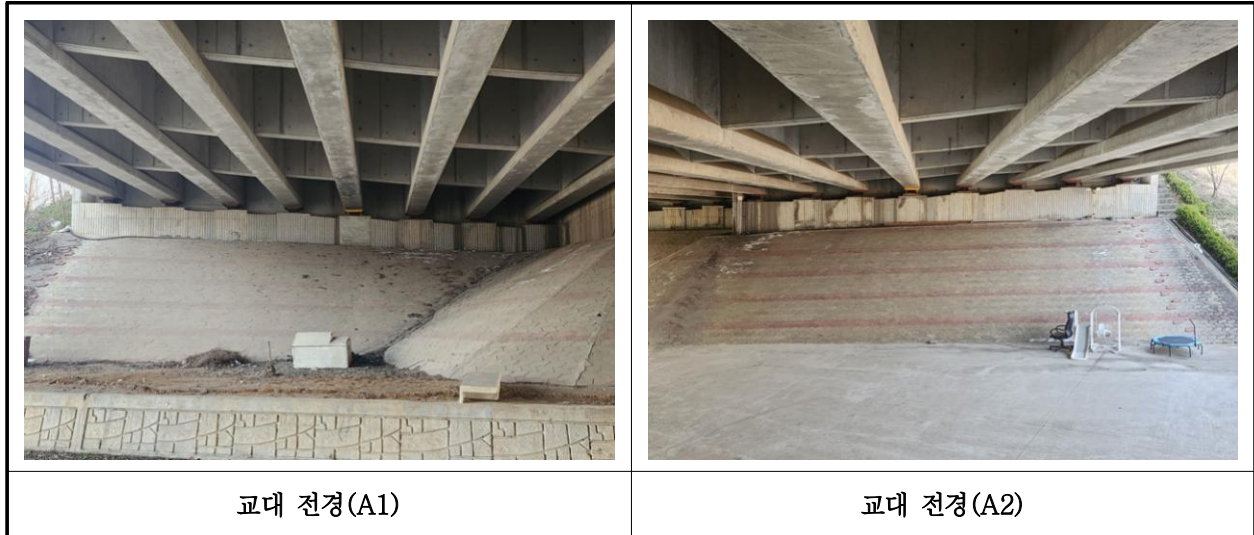
【사진 1.3.8】 교대 전경
