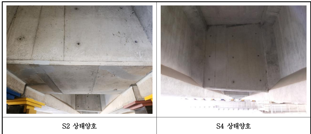
【사진 1.3.7】 가로보 손상현황
