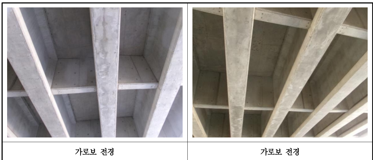
【사진 1.3.6】 가로보 전경
