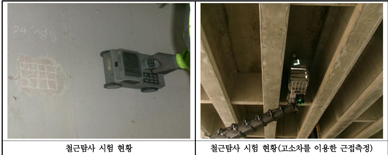
【사진 1.4.2】 철근탐사 시험
