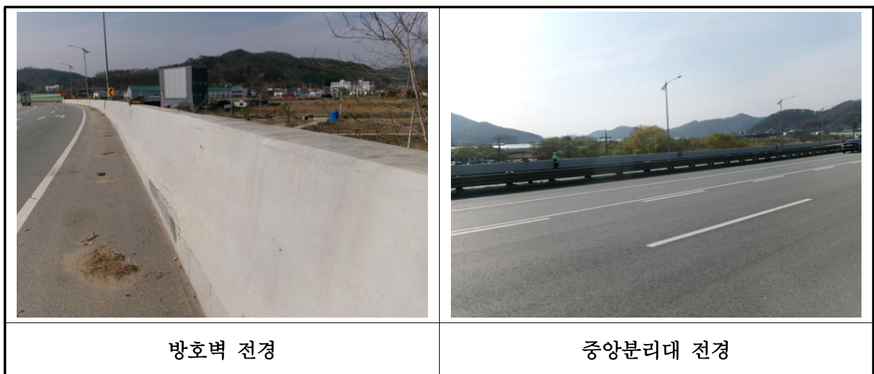
【사진 1.3.21】 난간 및 연석 전경
